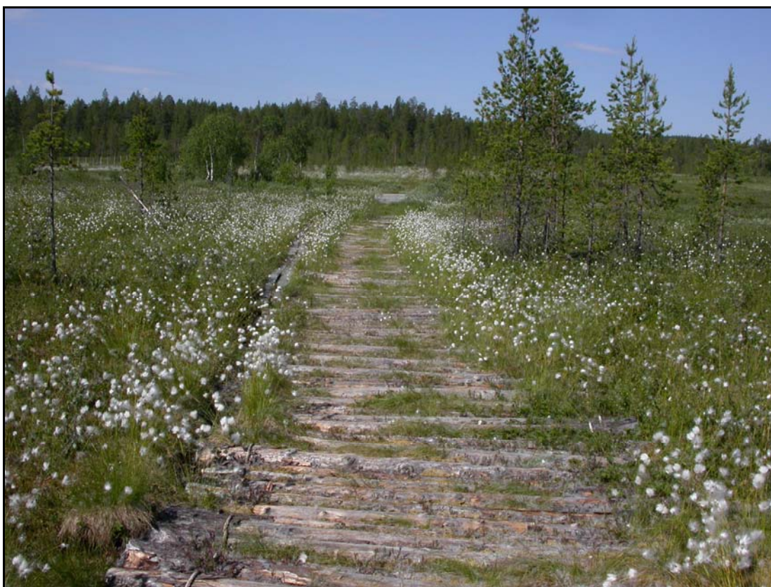
Figur 9: Forsterket kjørettrasé over myr mellom Grenseberget og Treriksrøysa. Foto: © Karl-Otto Jacobsen
